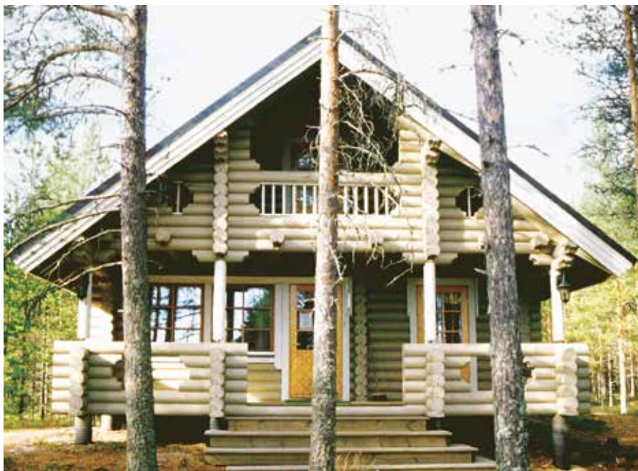
Foto 12. Esiletõstetud otsaseinaga tööstuslik palkhoone. Autori foto.
