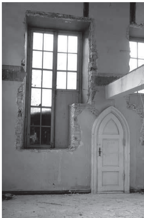
Foto 1. Restaureerimise käigus lääneseinast avanenud vanad aknad (V. Valderi foto)
