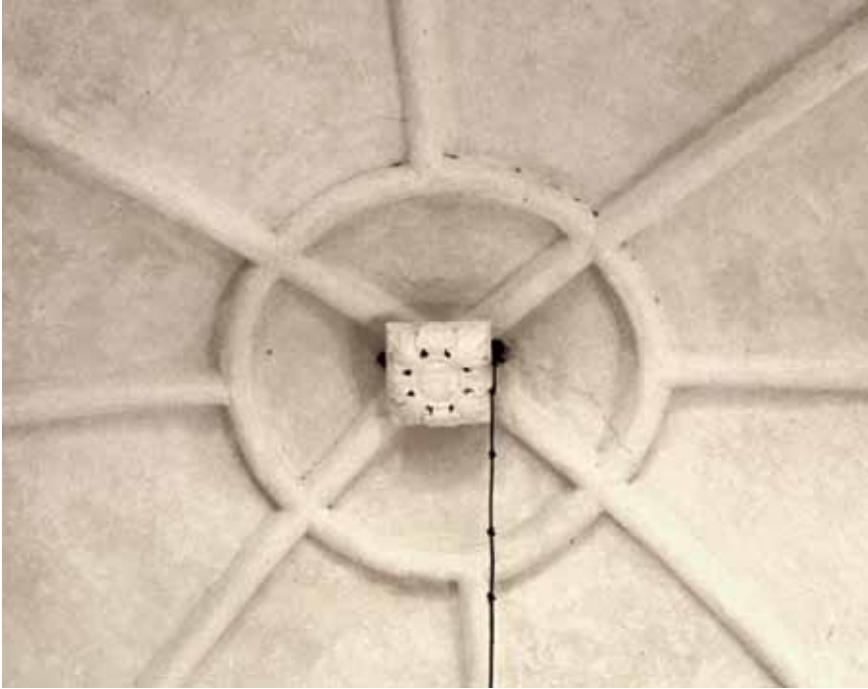
Abb. 23. Der Schlussring im Chorraum der Kirche zu Valjala. Foto von Kaur Alttoa.
