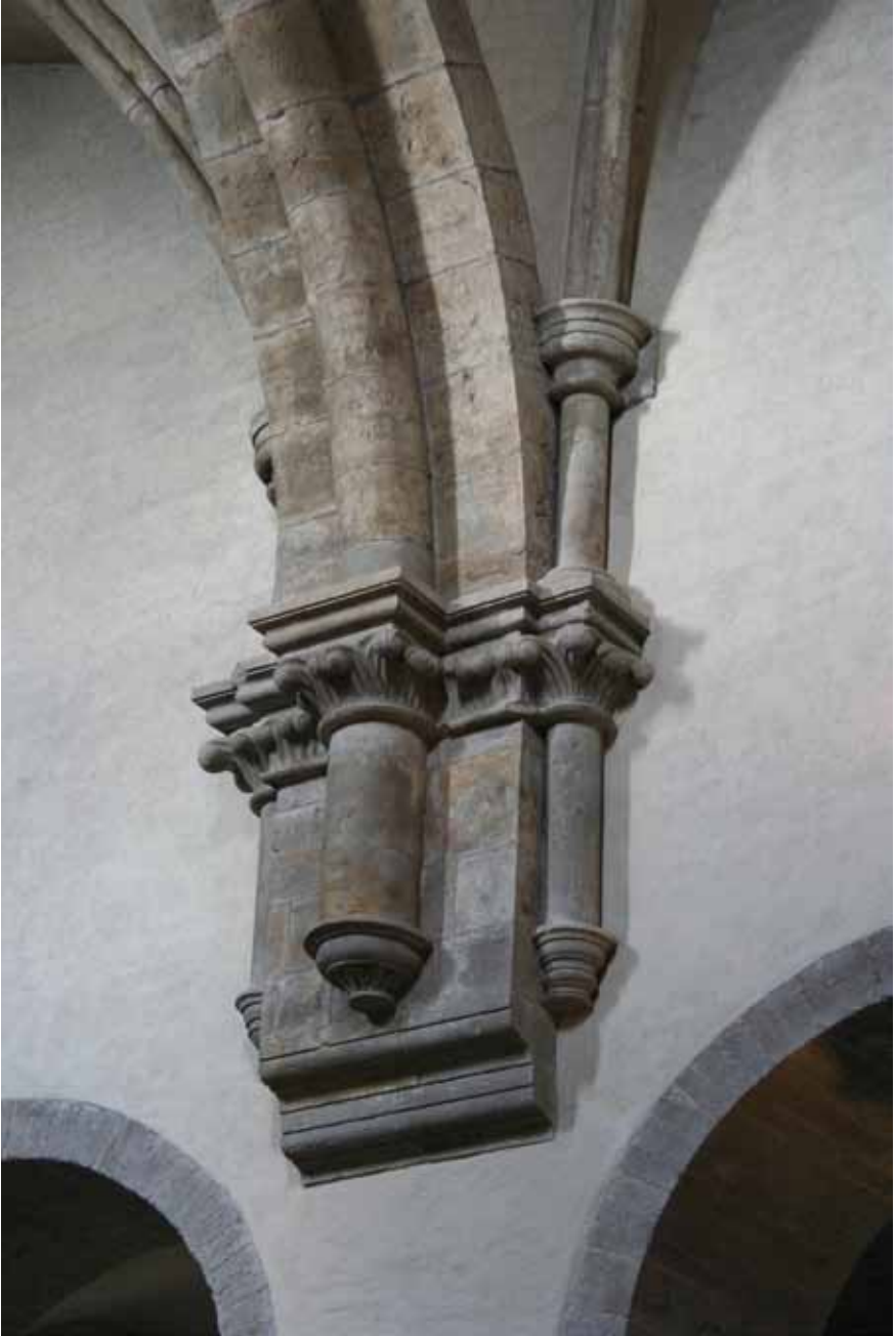
Abb. 16. Die Gewölbekonsolle in der Kirche in Varnhem. Foto von Kaur Altoa.
