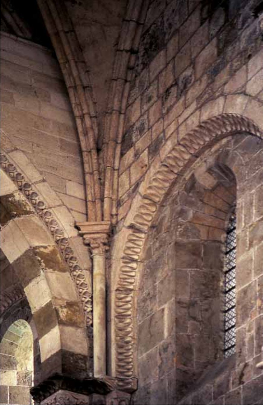
Abb. 6. Die Kirche von Vézelay. Eine Zwischenkolonette in der Übergangszone vom Langhaus in den neuen Chorraum. Foto von Kaur Altoa.
