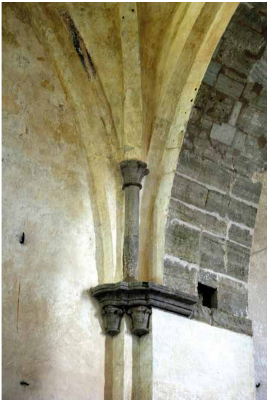
Abb. 3. Die Zwickelkolonette im Chorraum der Kirche von Kaarma. Foto von Kaur Altoa.
