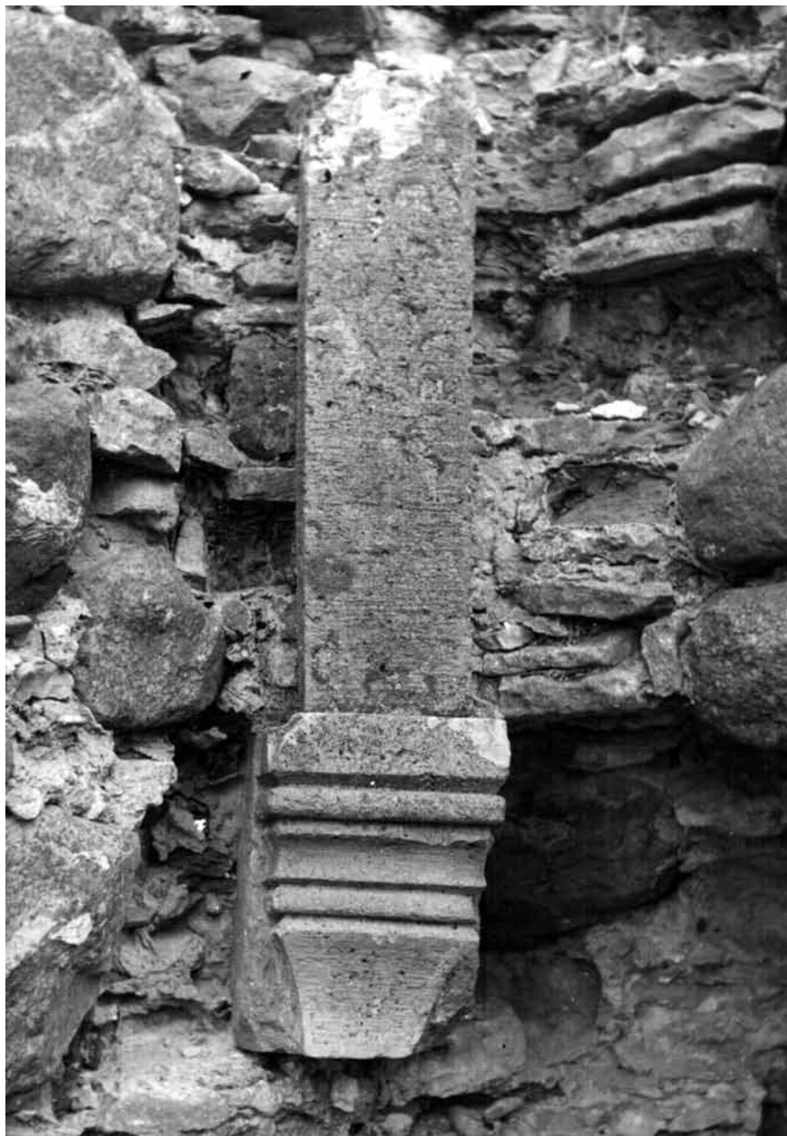
Abb. 10. Die Gewölbekonsolle und -rippe der nordöstlichen Ecke des Chores. Foto von Richard Kirchhoff, 1942.
