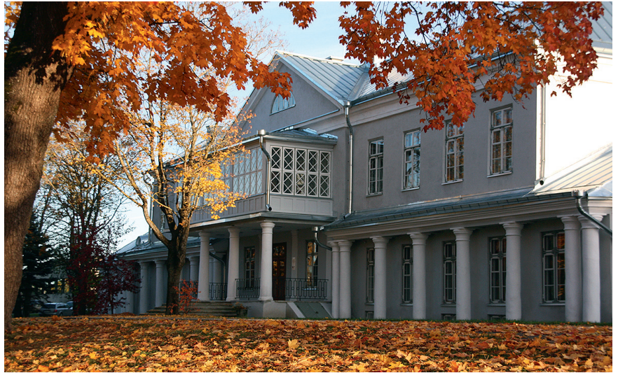
Foto 2. Äsja renoveeritud De la Gardie loss
