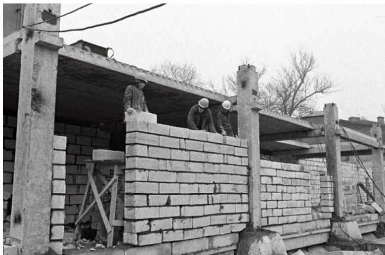
Kutsekeskkooli lõõktöölised Ravi tn silmakliiniku ehitusel 1983. aastal. Ükski tuhaploki rida pole sirge. Vundamendikannude jootebetoon on lohakalt maha nõrgunud.
