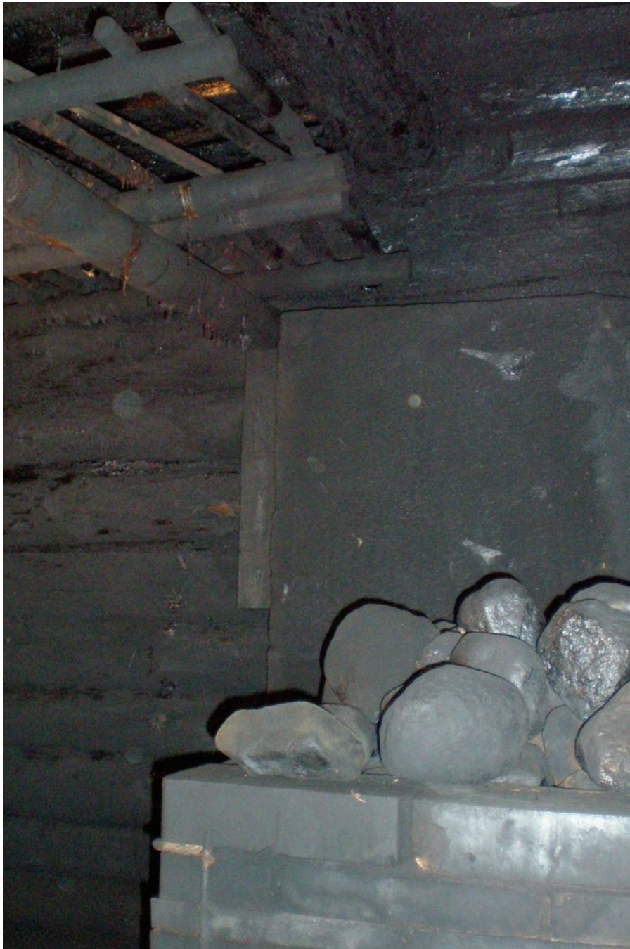
Foto 1. Vana talusauna sisevaade. Selles saunas suitsutatakse mitu korda aastas liha. Seintele ja lakke koguneb kütmistega nõgi, mida tuleb aeg-ajalt eemaldada. Puitseina kaitseks on kerise kõrvale seinale pandud tuletõkkeplaat ja selle peale veel suurem plekktahvel, et ära hoida kerise kõrval oleva palkseina süttimist. Foto MTÜ Võro Selts VKKF kogust, pildistanud Nele Reimann-Truija, 2010.
