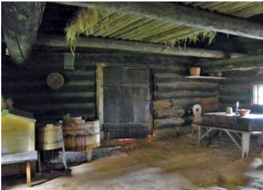
Foto 6. Põlva Talurahvamuseum Karilatsi külas. Rehetoa sisevaade. Parte (peened pikitaladega risti asetsevad ümarad latid) peale pandi vili, mida kuivatati reheahjust eralduvas soojuses. Doug Reedi foto.
