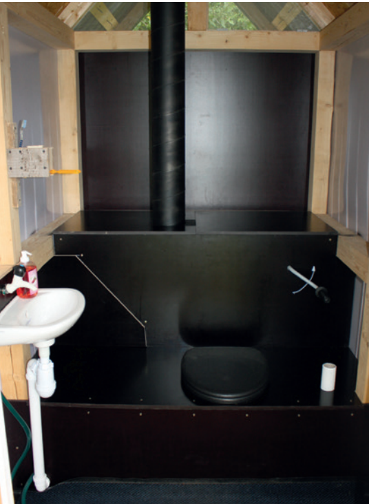
Foto 6. Valminud käimla sisevaade. Oliver Tätte foto.
