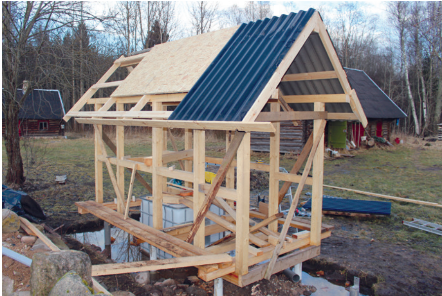
Foto 1. Välikäimla ehitus on jõudnud katusekatte paigalduseni. Siseruumi osas kasutasin eterniitkatte all ka OSB-plaati. Oliver Tätte foto.
