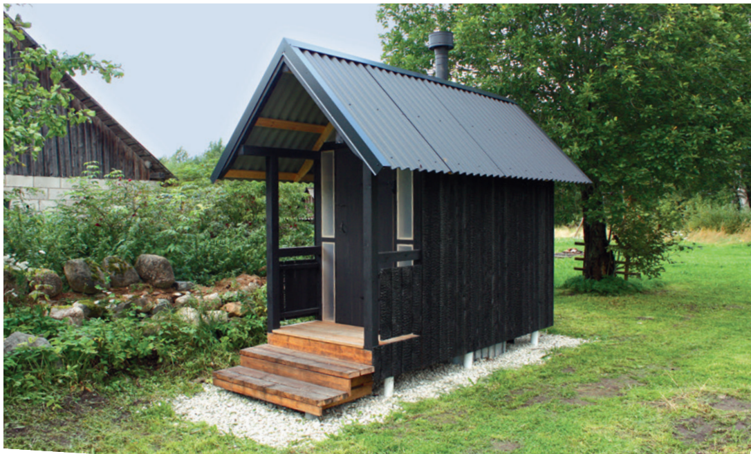
Foto 7. Valminud käimla välisvaade. Oliver Tätte foto.
