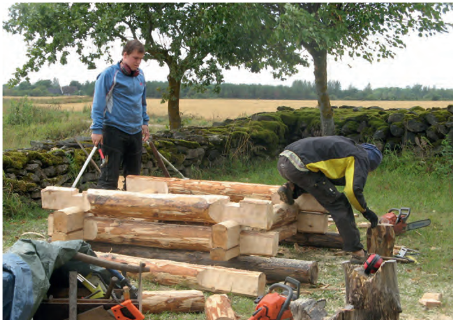
Foto 10. Ristpalkidest kaevurakke valmistamine. Laur Oberschneideri foto.
