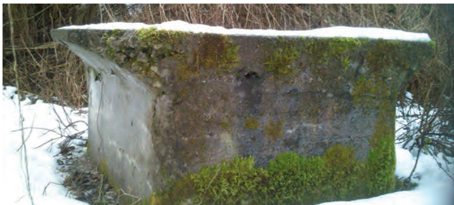
Foto 4. Betoonist valatud maapealne kaevurake Mäense külas Läänemaal; samasugune on ka Kaasiku talus Ullaste külas. Laur Oberschneideri foto.
