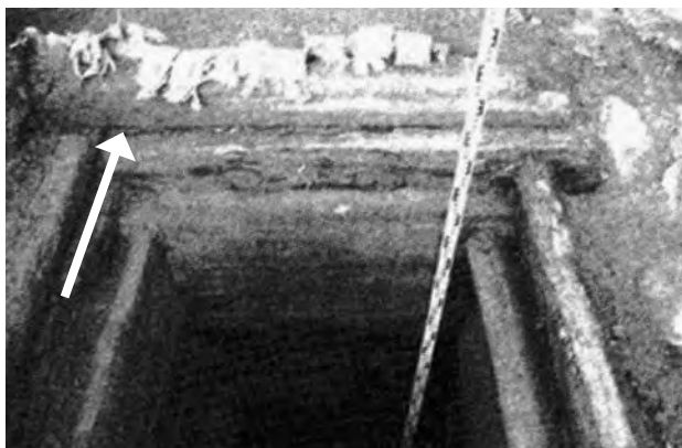
Foto 2. Salvkaev Narva börsihoones. Nool osutab kasetohust hüdrosolatsiooni kihile. (Kriiska, Ivask 2012: 106.)
