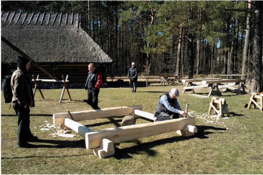
Foto 1. Janne Jokelainen Seinäjoki rakenduskõrgkoolist viib läbi käsitööriistadega möögateranurga (sm sulkanurkka) õpituba Eesti Vabaõhumuuseumis. Priit-Kalev Partsi foto.
