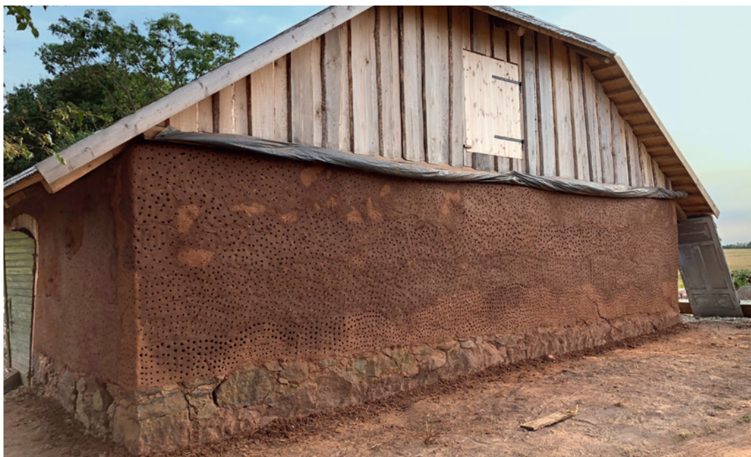
Foto 11. Neljas täitekiht. Augud on sisse tehtud krohvikihi paremaks kandmiseks ja kuivamise kiirendamiseks. Malvo Tominga foto.
