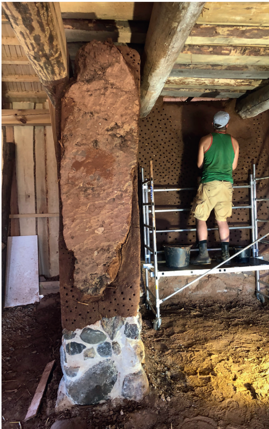
Foto 8. Taastatud saviseina profiil, millelt annab välja lugeda ka olemas olnud saviseina toetuspinna suurust soklile. Malvo Tominga foto.
