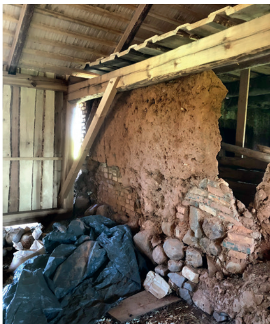
Foto 1. Küünipoolne savisein. Seina oli kõvasti lapitud ja algsest saviseinast on alles jäänud vaid väike osa ebastabiilset seinosa. Malvo Tominga foto.
