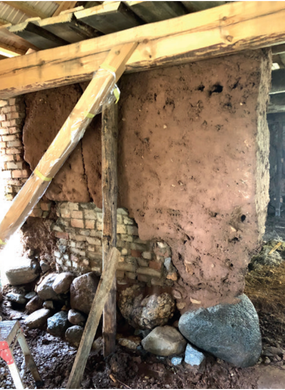
Foto 7. Puhastatud savisein. Sellise seina taastamise mõttekus on kaheldav, kuid me tegime seda siiski. Malvo Tominga foto.
