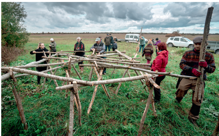
Foto 13. Kuhjalava põhikonstruktsioon, millele lisasime tihendamiseks juurde jämedamaid lepakaikaid. Sander Koidu foto.
