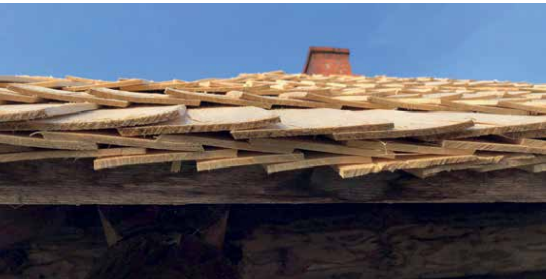
Foto 1. Vaade kolmekihilisele laastukattele räästa suunast. Puusaare talu saun, Jüri Metsalu lõõdud katus, kevad 2024. Foto Mikk Tagapere.
