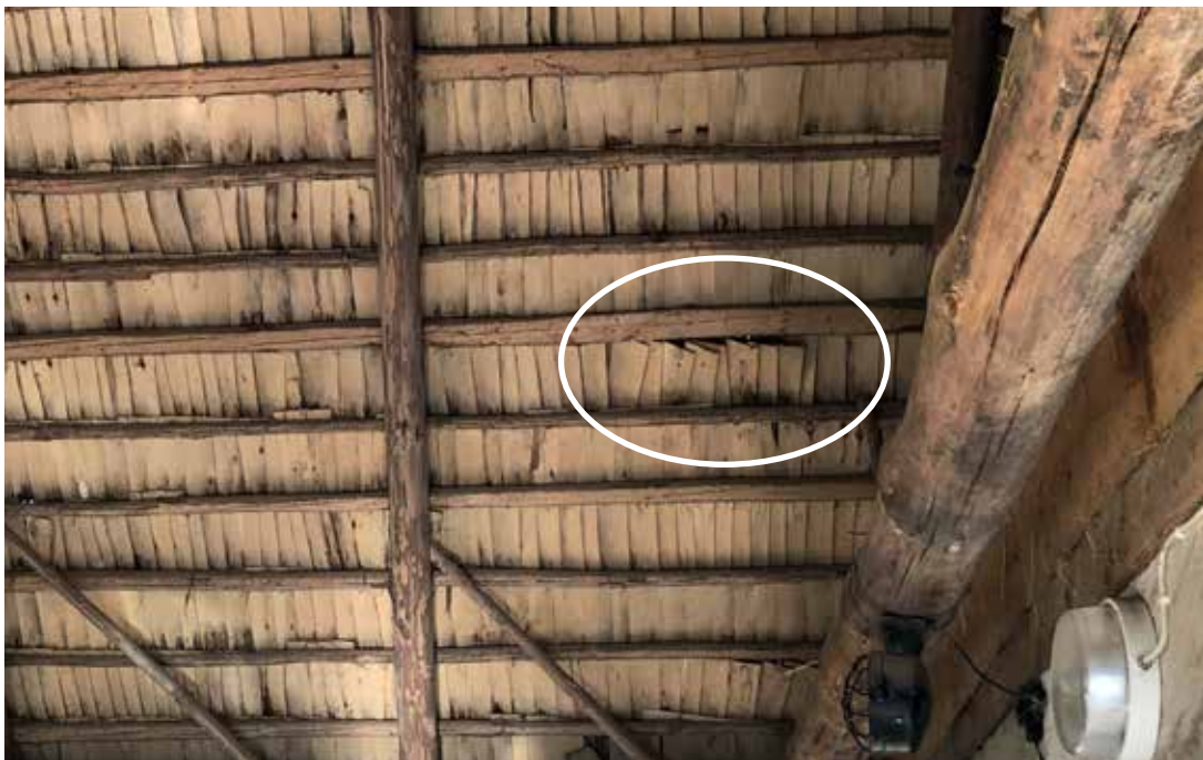
Foto 5. Roovilt maha vajunud laastud. Puusaare talu laut. Foto Mikk Tagapere, 2024.
