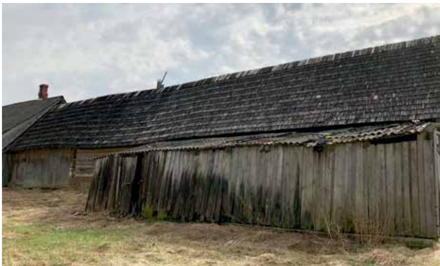
Foto 3. Okaspuulaast katuse põhjaküljel. Harjalaud puudub ja harjalaastud on hiljuti asendatud. Mesipuu talu laut-heinaküün. Foto Mikk Tagapere, 2024.
