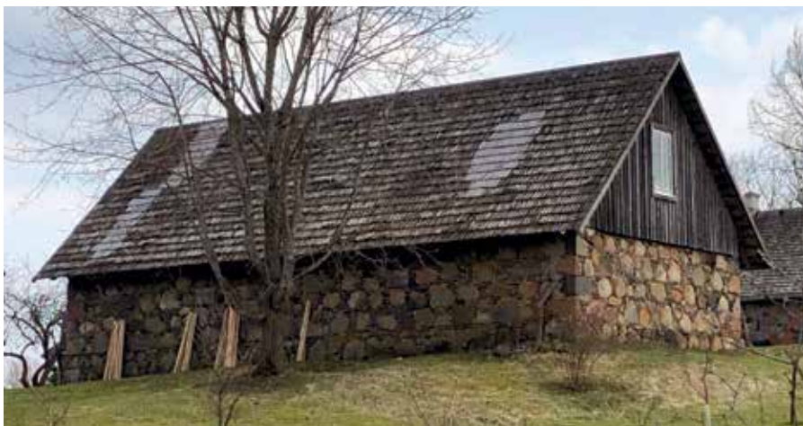
Foto 11. Kohtparandused eristuvad ülejäänud katsepinnast heledama tooni poolest, kuna värske laast on ilmastikust mõjutamata. Palovere talu laut. Foto Mikk Tagapere.
