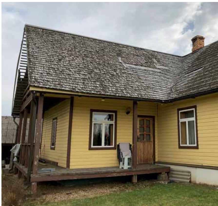
Foto 8. Mesipuu talu elumaja laastuga kaetud katuseneel on vajanud parandamist. Foto Mikk Tagapere, 2024.
