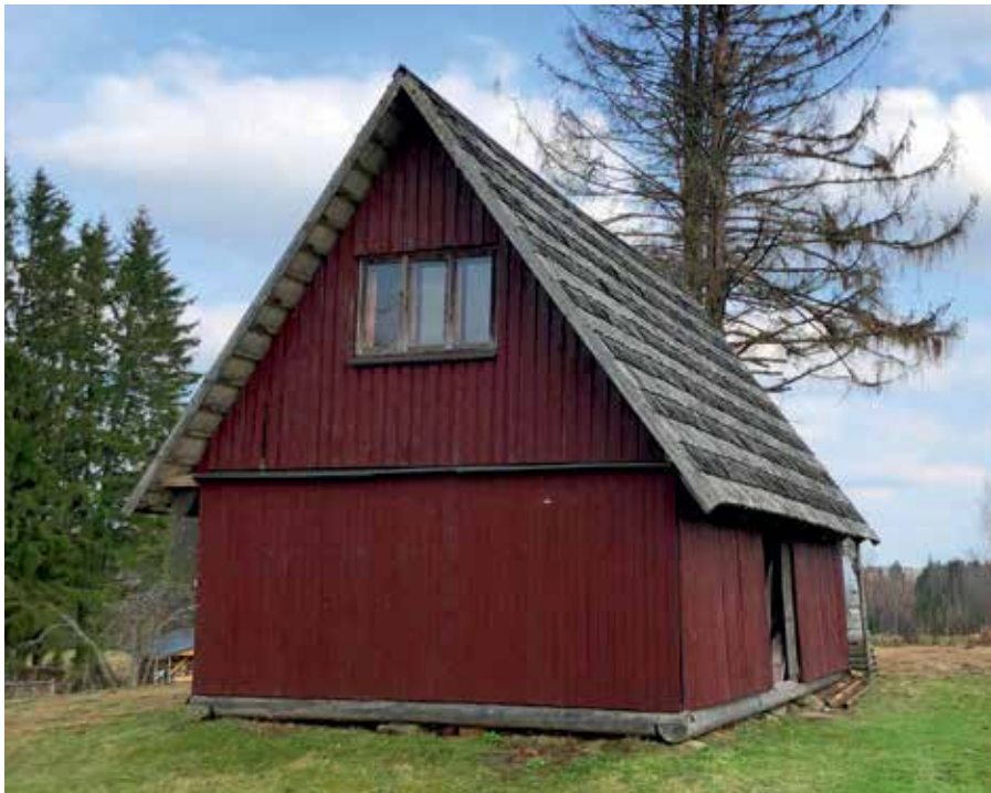
Foto 7. Palovere talu puukuuril on keskmisest teravama kaldega katus. Foto Mikk Tagapere, 2024.
