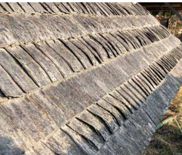
Foto 2. Haavalaastu kõmmeldumine katusel. Puusaare talu, Jüri Metsalu varjualuse katus. Foto Mikk Tagapere, 2024.
