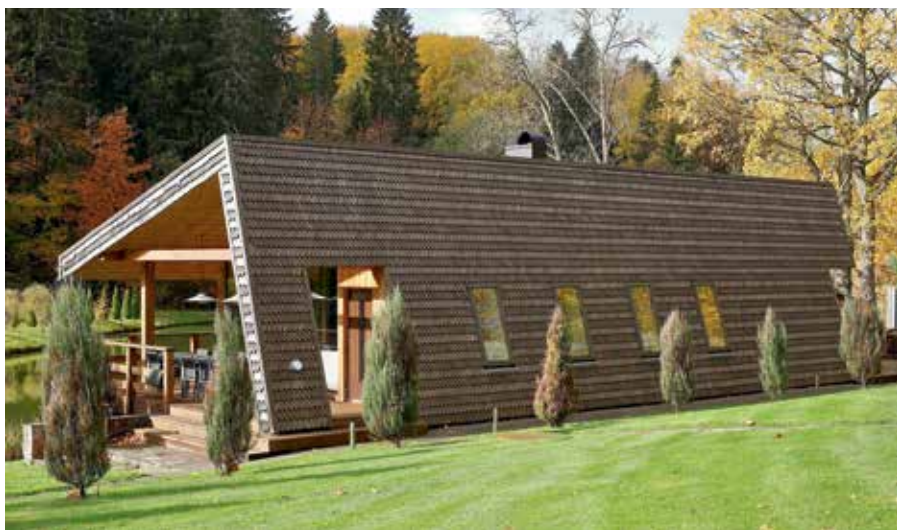
Fotod 15 ja 15a. Elamu ja saunamaja Haanjas. Arhitekt Karmo Tõra, 2016.
