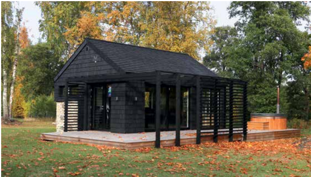
Foto 12. Suveköök Eismal. Arhitekt Diana Taalfeld, 2021.
