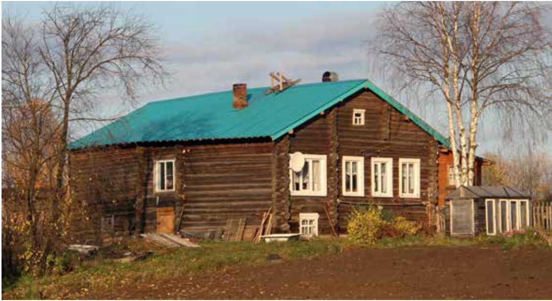
Foto 9. Uue plekk-katusega saja aasta vanune maja Kulõmdini külas. Foto Art Leete, 2014.
