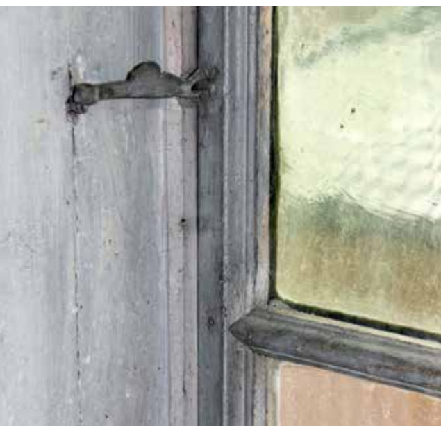
Foto 7. Stiftsgårdens lõunatiiva lõunaakna lengi ja püstraampuu liitekoht. Foto Thor-Aage K. Heiberg, 26. märts 2025.
