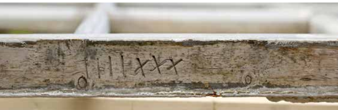
Foto 6. Stiftsgårdens aknaraami ülemisele pöikraampuule löigatud märgid, mis meie arvates on asendimärgistus. Kahel raamil, mida me uurisime, on märgid XXX I ja XXX IIII. X tähistab konkreetset aknalengi ja I viitab aknaraami positsioonile vahemikus 1 kuni 4. Foto Thor-Aage K. Heiberg, 9. aprill 2025.
