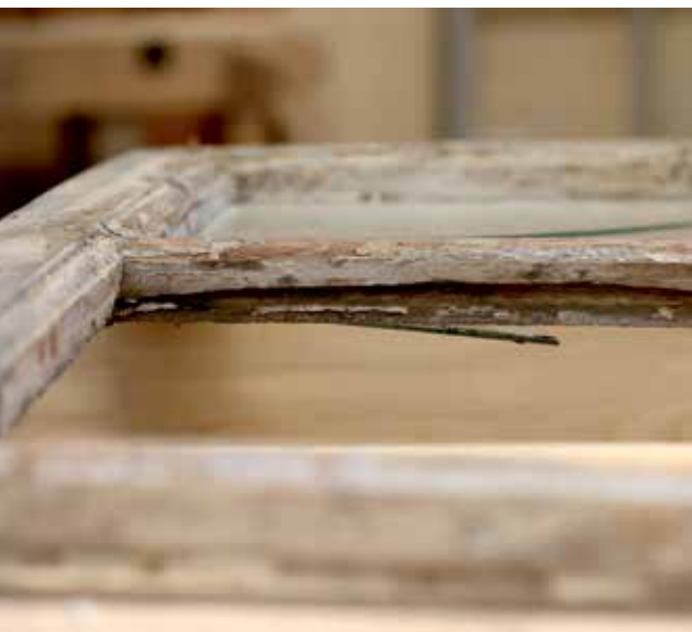
Foto 10. Kumerale klaasile kohandatud klaasivaltsiga prosspulk. Foto Thor-Aage K. Heiberg, 18. veebruar 2025.
