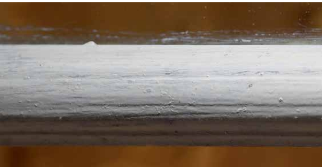
Foto 9. Ühe Stiftsgårdeni aknaraami prosspulga detail, millel on näha ülalkirjeldatud jooni, mis on meie arvates tööriistajäljed. Foto on tehtud külvalgusega, et esile tuua jooned, mis muidu palja silmaga nähtamatuks jäävad. Valgus tekitab varju prosspulga küljele, mistõttu võib pross fotol tunduda tegelikust veidi kitsam. Foto Thor-Aage K. Heiberg, 9. aprill 2025.
