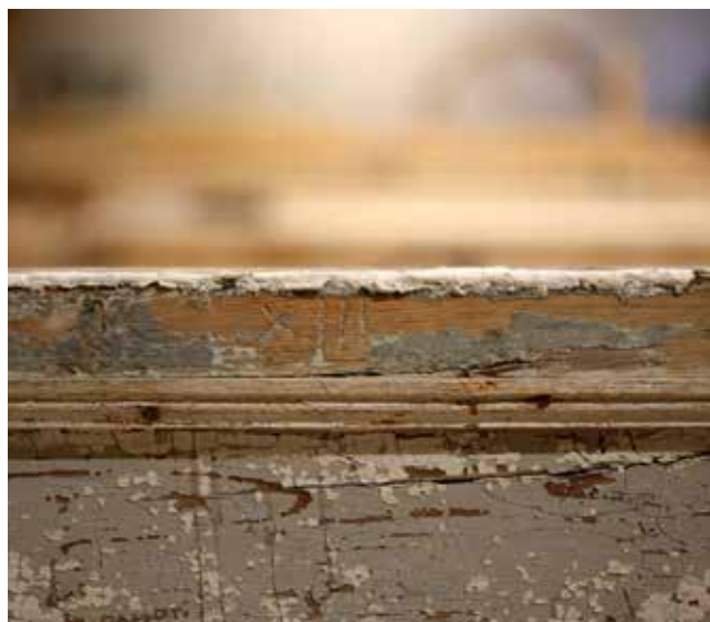
Foto 12. Eidstu akna leng ühega kahest asendimärgist (X III ja X IIII). Tegu tundub olevat sama märgistamissüsteemiga kui Stiftsgårdeni akandel. Foto Thor-Aage K. Heiberg, 7. märts 2025.
