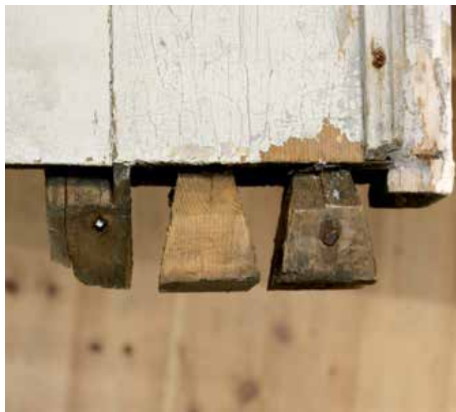
Foto 13. Eidstu aknalengi kalasabatapid on nurga all faasitud, et paremini sobituda tappidesse. See tagab väga tiheda ühenduse, mis jääb seetõttu aknaraami siseküljelt vaadates varjatuks. Foto Thor-Aage K. Heiberg, 28. veebruar 2025.
