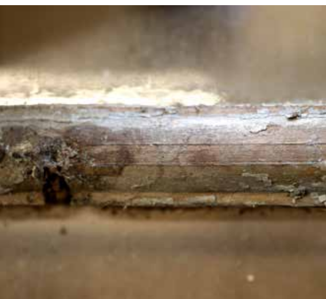
Foto 11. Ka Eidstu aknaraamide prosspulkadel on ülaosas kaks teineteisest veidi eemal asetsevat joont, kuid nende vahel ei tundud olevat lamedat ala nagu Stiftsgårdeni akendel. Pigem tunduvad need hõövliraua nurga jälgedena. Foto Thor-Aage K. Heiberg, 18. veebruar 2025.
