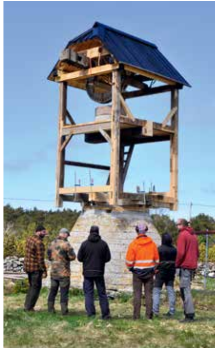
Foto 3. Vilsandi Kaheveski tuuliku põhi-konstruktsioon taastati talgute käigus 2022. aasta mais, millele järgnes laudadest katusekatte, välislaudise ja tiibade paigaldamine. Tuuliku tiivad valmistati eelnevalt OÜ Lükkepakk meistrite poolt Hiiumaal. Talgute tulemusel sai tuulik töökorda. Foto Andres Uus.
