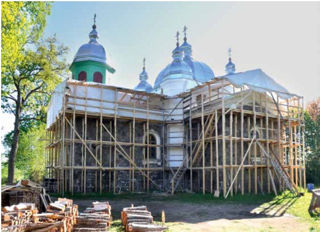
Foto 15. Lalsi kirik. Löövid on täies ulatuses ümbritsetud tellingutega. Foto Andres Uus.
