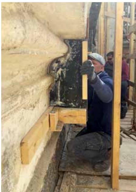
Foto 14. Lalsi kirik. Karniisi kasvatamine lubimördiga. Vajalik kuju anti karniisile šablooniga. Foto Andres Uus.
