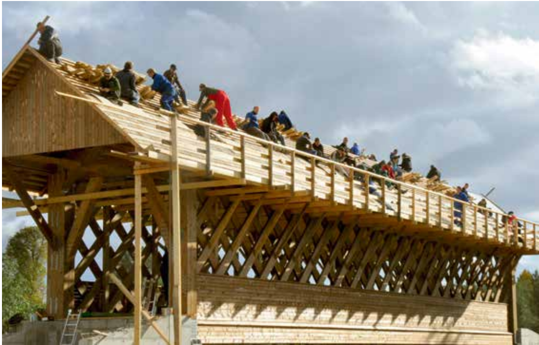
Foto 1. Järuska silla laastukatuse ehitustalgud Eesti Maaülikooli tudengitega 2012. aasta sügisel. Eesti esimene ja seni ainus katusega puitsild Ida-Virumaal, Rannapungerja jõel sai pealesõidud, teepiirded ja märgistuse 2013. aasta suveks. Foto Andres Uus.
