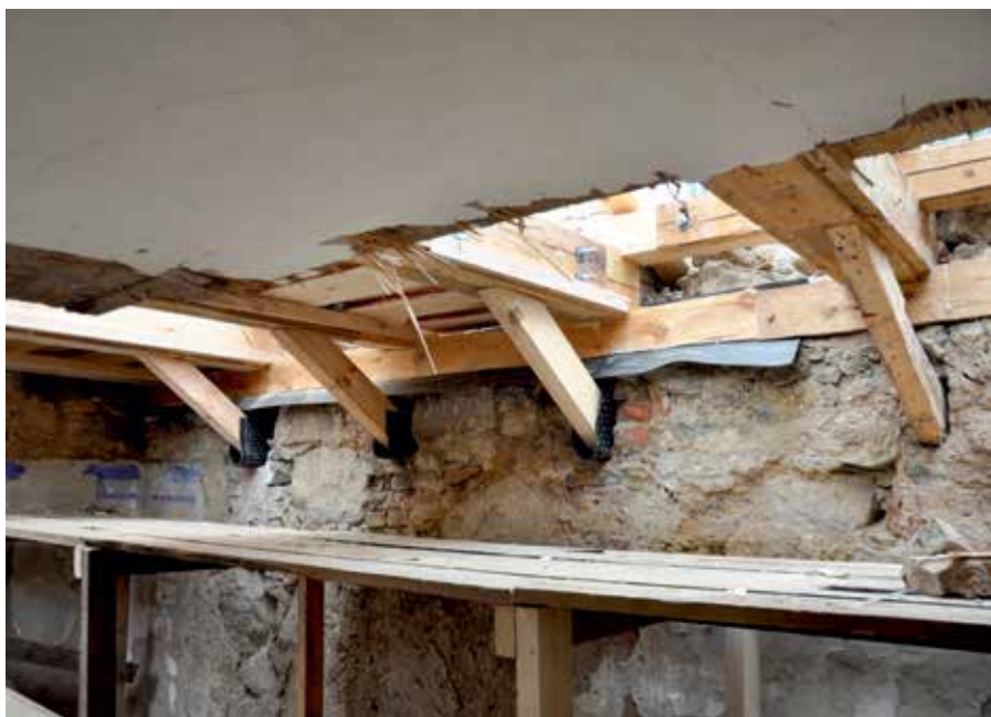
Foto 16. Lalsi kirik. Peegelvõlvi puidust roided põhjalöövi laes. Foto Andres Uus.
