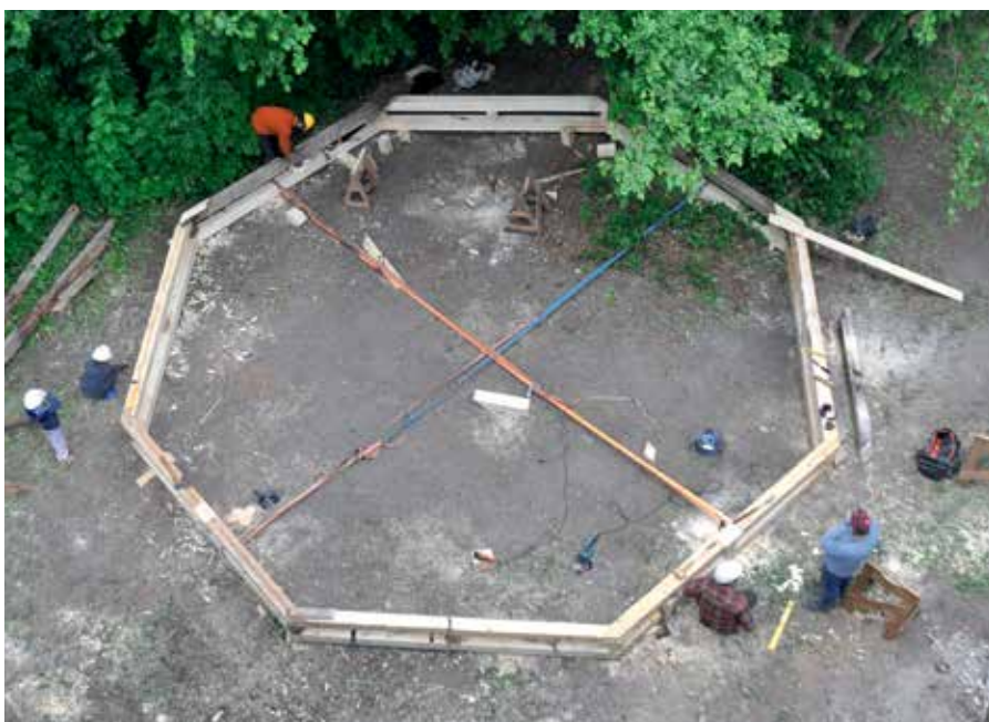
Foto 12. Lalsi kirik. Tambuuritorni alusvöö on tornist alla toodud, kahjustunud detailid asendatud koopiatega ja kogu konstruktsioon maapinnal uuesti kokku monteeritud. Foto Andres Uus.
