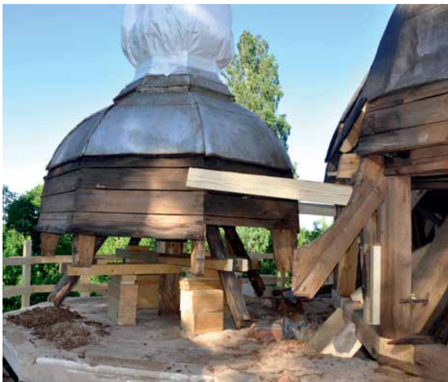
Foto 10. Lalsi kirik. Nurgatorni alusvöö on demonteeritud ja torn ajutiselt toetatud. Foto Andres Uus.
