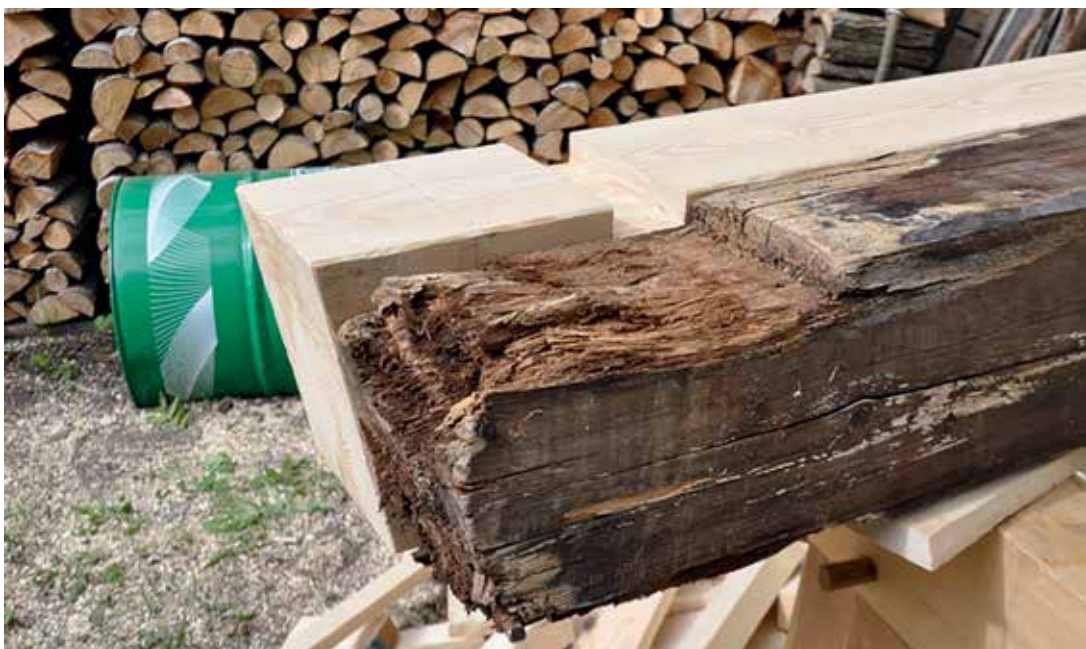
Foto 11. Lalsi kirik. Pehkinud või hävinud detailid asendati koopiatega. Foto Andres Uus.
