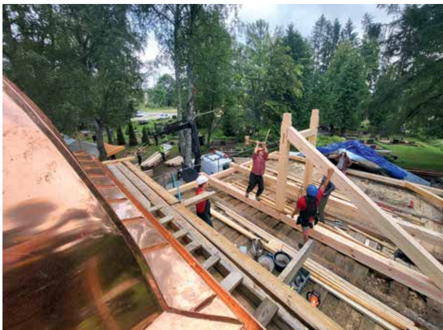
Foto 5. MTÜ Vanaajamaja meeskond kasutas Miiakse kiriku uue pruss-sõrestikkatuse ehitamisel traditsioonilist nõorlood meetodit. Foto Mikk Mustmaa.
