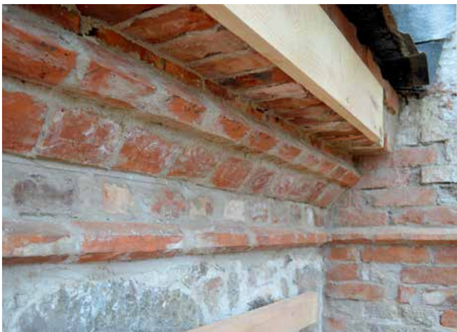
Foto 13. Lalsi kirik. Lõik telliskarniisi on uuesti üles laotud ja krohvimiseks ette valmistatud. Foto Omar Linna.
