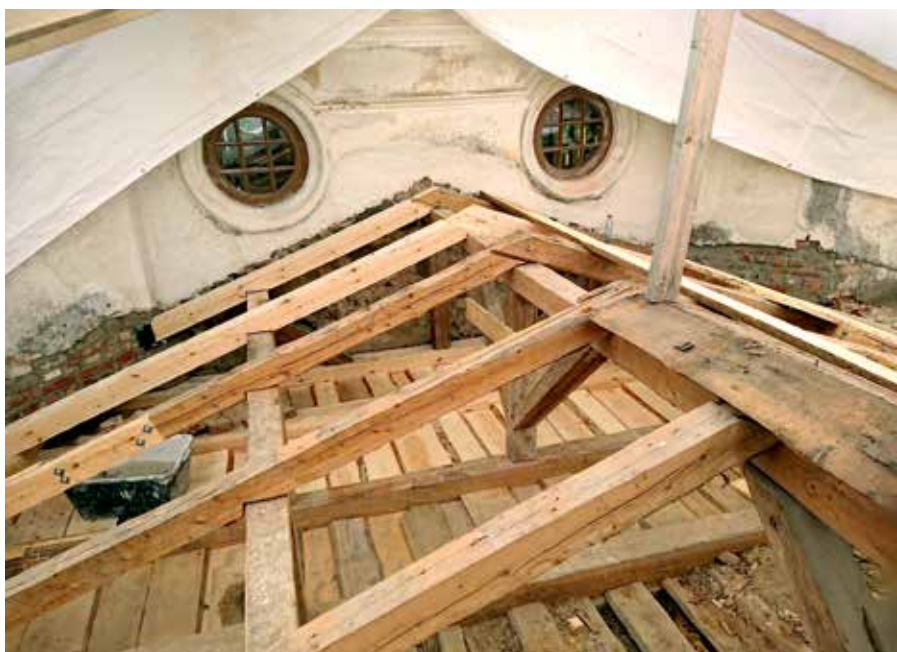
Foto 17. Lalsi kirik. Põhjalöövi katus on täies ulatuses avatud ja kahjustunud konstruktsioonid uuendatud. Ehituse ajaks kaeti lõõv ajutise varikatusega. Foto Andres Uus.
