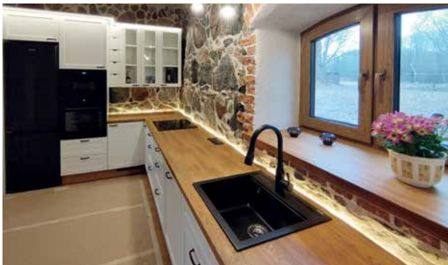
Foto 22. Kööginööbli tagune sein ja aknapaale on kaetud termo- ja lubikrohvi, 22.03.2024. Foto Tiina Angerjäär.
