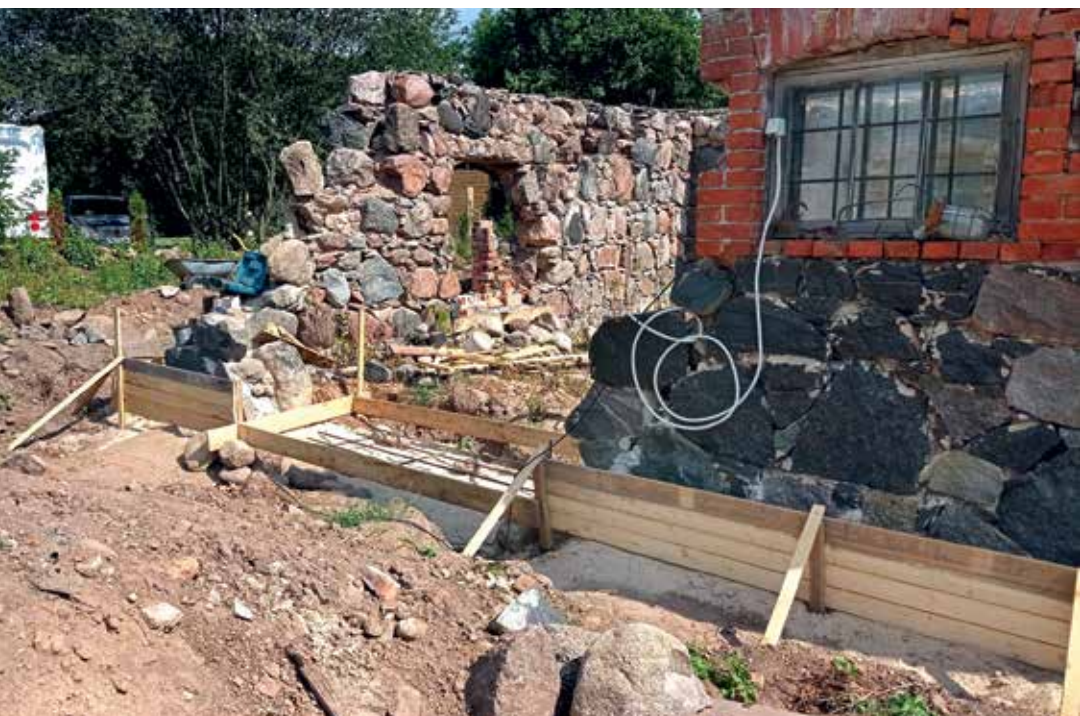
Foto 4. Armeeritud raketis (saalung ehk ajutine konstruktsioon) ootamas betoniautot. Foto Tiina Angerjäär.
