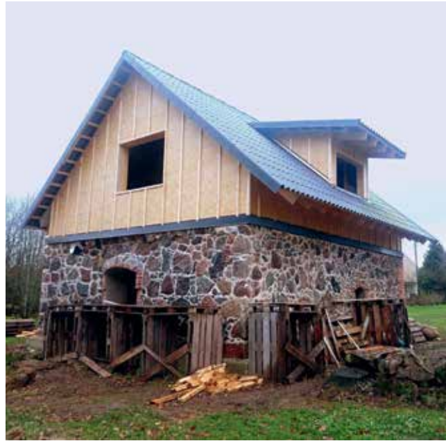
Foto 17. Kelbaotsad ehk otsaseinad ja küljed said talveks kinni, 8.11. 2022. Foto Tiina Angerjäär.
