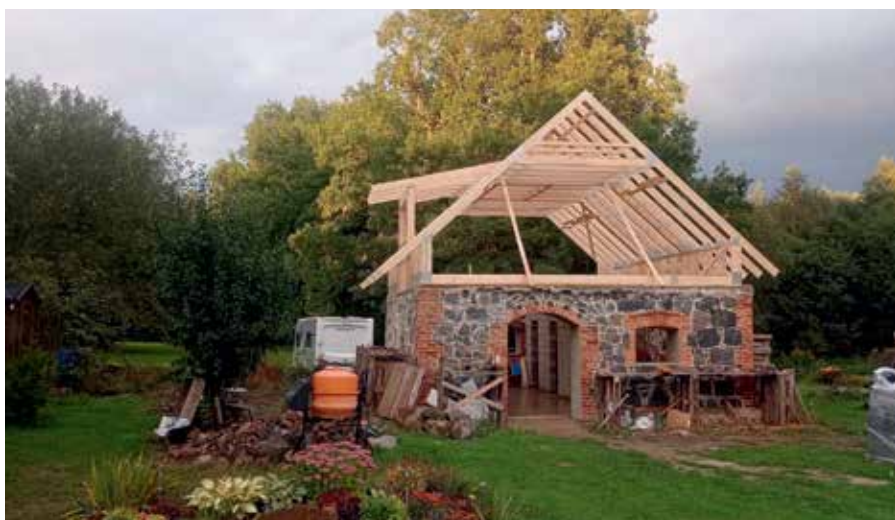
Foto 15. Paigaldatud katusefermid, 16.09.2022. Foto Tiina Angerjäv.
