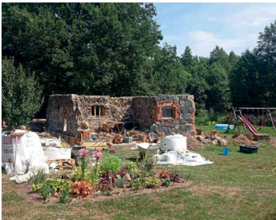
Foto 6. Sakret ZM ja Sakret KZM2 1000 kg segukotid.
