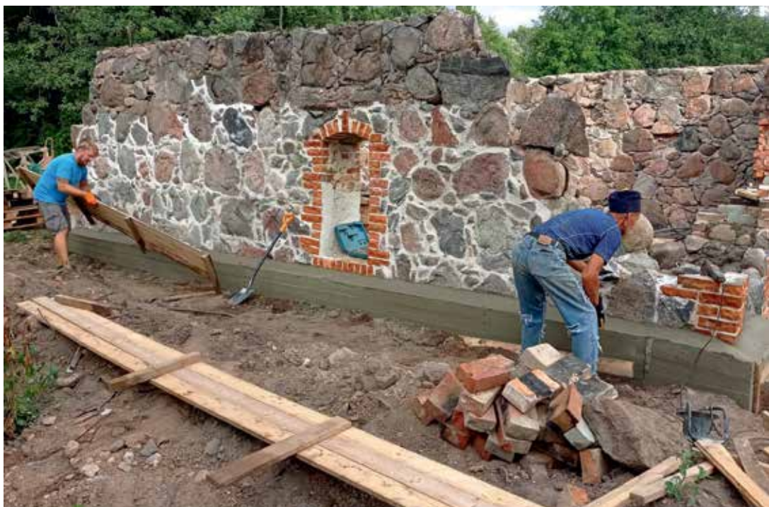
Foto 5. Raketise eemaldamine kivistunud vundamendilt.
