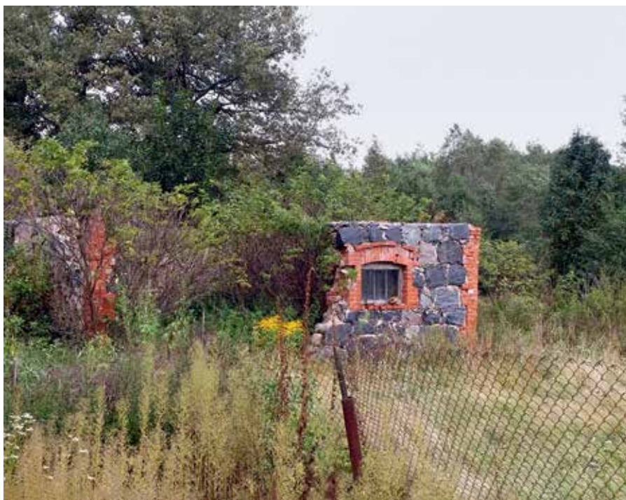
Foto 2. Laudahoone välisilme enne renoveerimist, 04.09.2014. Hoone välismõõtmed on 7,2 \times 8,6 m, kogupindala 61,92 \text{ m}^2 , suletud esimese korruse netopind 54,3 \text{ m}^2 . Foto kinnisvaraportalist.
