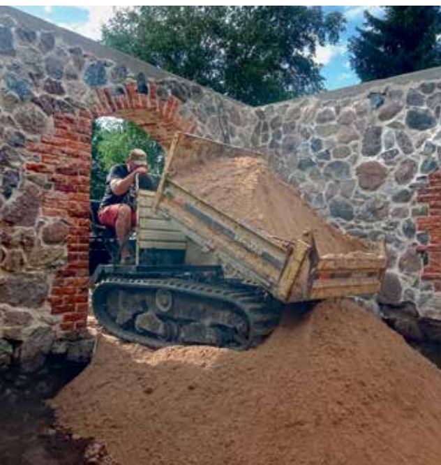
Foto 12. Tagasitäide liivaga, 07.07.2022. Foto Tiina Angerjärvi.
