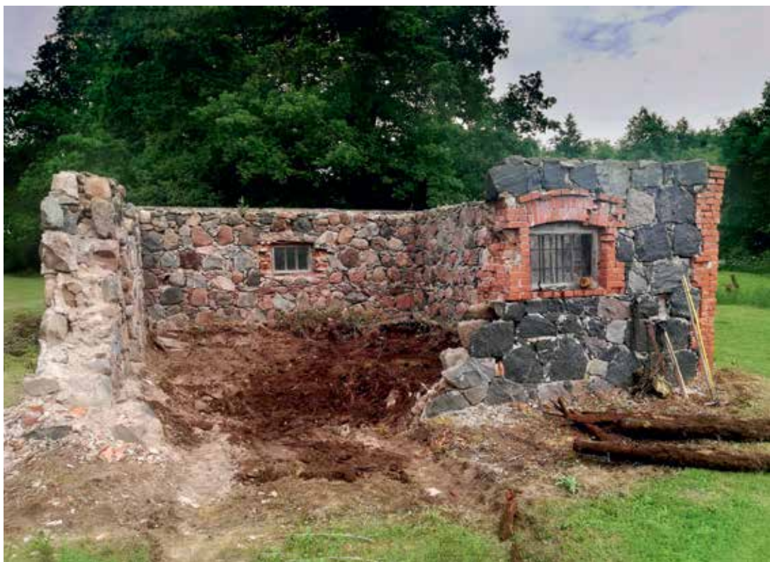
Foto 3. Sellises lagunemisasemes maakiviehitise taastamise on praktilise tasuvuse seisukohalt kaheldav, kuid kõigest hoolimata alustasime 2020. aastal töödega. Müüride vahelt ja pealt on eemaldatud puud ning lahtised ja varisemisohhtlikud kivid. Hoone ümbrus on kopaga puhastatud. Foto Tiina Angerjäär.
