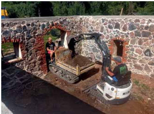
Foto 11. Mulla väljavedu 1,5-tonnise kopa ja minikalluriga. Foto Tiina Angerjäär.
