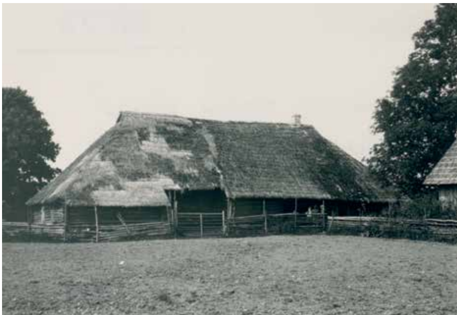
Foto 4. Mudare talu Abjas. Katuseharja kattev materjal on kinnitatud lati alla. Foto Ilmari Manninen, 1925. ERM Fk 451:20.
