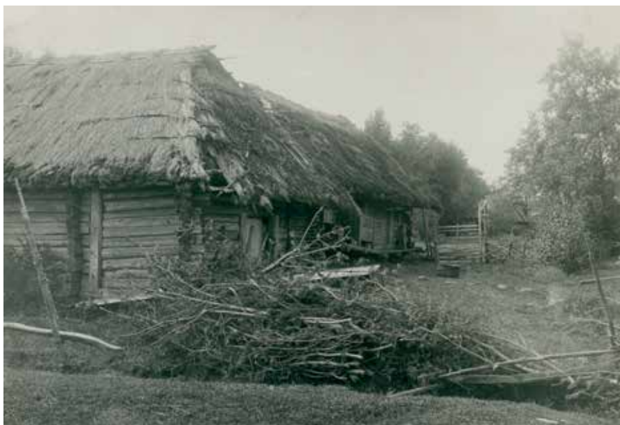
Foto 1. Ojapera talu Jakobimõisa külas Tarvastu vallas Viljandimaal. Katuseharjal on jälgitav üle harja kinnitatud ölekubude rütm. Talu asub 6 km kaugusel Ritsu popsitalust.
