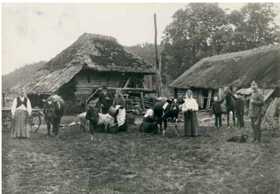
Foto 2. Nälgu talu Kivilõppe külas Tarvastu vallas Viljandimaal. Talu asub umbes 10 km kaugusel Ritsu popsitalust. Mõlemal katusel on näha üle harja kinnitatud ölekubud.
