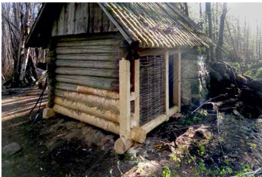
Foto 12. Foto 12. Ehituse praktikal Hiiumaal, mai 2018. Praktika käigus remonditud saun-paargu. Saunal olid palgid pehastunud ja lääpa vajunud. Palgid said vahetatud ning saun tõsteti loodi tagasi. Foto: Marko Aatonen.
