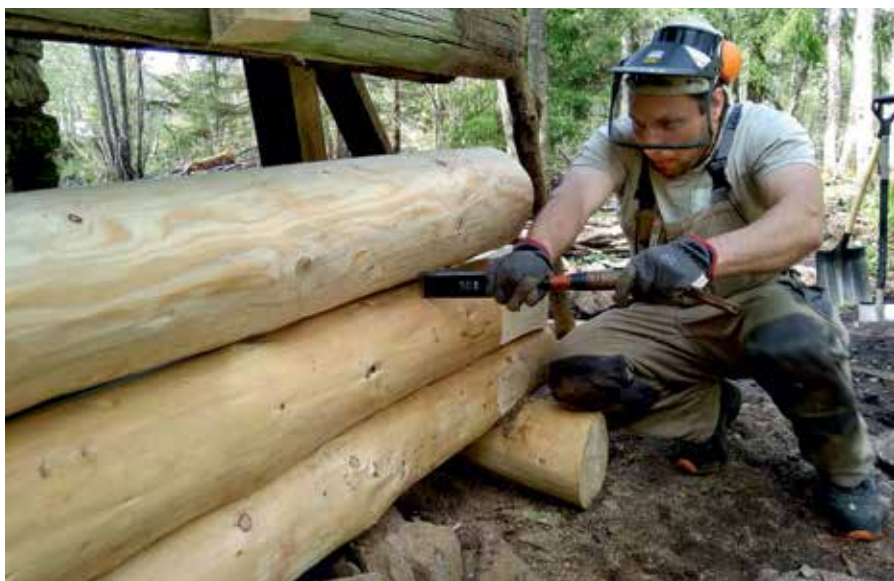
Foto 10. Ehituse praktikal Hiiumaal, mai 2018. Palgi vara märgib Jürgen Annuk. 2025. aasta ehituse eriala vilistlane Kaija Kängsepp meenutab: „Ega me siis kogu aeg klassis ka polnud. Erialajuht Leele Välja hoolitses, et me saaks ikka ennast ka Viljandist väljas tuulutada. Nüüd parafraseerin Orelipoisi laulu „Ringi käisin“: Lätis ma käisin, Rootsis ma käisin, Norras ma käisin, Hiiumaal ma käisin, Setomaal ma käisin, Soomaal ma käisin, Matsalus ma käisin, talust tallu ma käisin, joonistamas ma käisin, Loodil ma käisin, saunas ma käisin, palgikojas ma käisin, Kobrul ma käisin, Moostes ma käisin, konverentsil ma käisin, Ohuvabas ma käisin, metsas ma käisin. Mõned mehed käisid isegi Ameerikas.” Foto Marko Aatonen.
