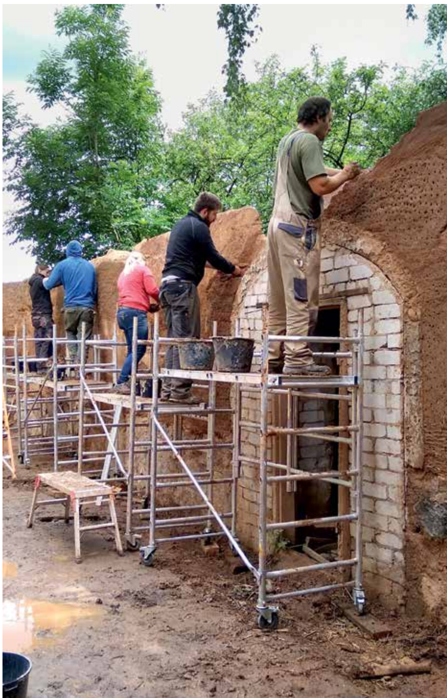
Foto 16. Saviehituse praktika, mida juhendas Malvo Tominga, 2018. Savihoone taastamine kohaliku saviga. Pildil vasakult: üliõpilased Kristiina Kesküla, Freddy Tints, Maarja Niinepuu, Martin Nõmmik ja Jürgen Annuk. Foto: Marko Aatonen.
