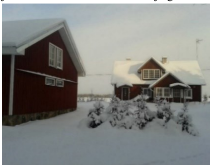
Foto 7. Kaasiku metsatalu elamu ja abihoone; fotografeerimise ajal jäi selja taha küps kuumsemets (vt ka fotod 6 ja 9). Tänaheks on see suures osas uuendatud kuuse ja kasega).
