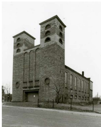
Foto c4: Rakvere Pauluse kirik (arhitekt Alar Kotli), mida nõukogude ajal kasutati võimla-spordihoonena, käesoleval ajal restaureeritakse maestro Arvo Pärdi muusikamajaks. 288
