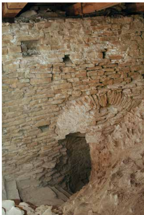
Abb. 12. Rechts der Treppengang, links die Treppenstufen, die im Laufe der Errichtung der Gewölbe hinzugefügt worden sind. Foto Kaur Altoa 2013
