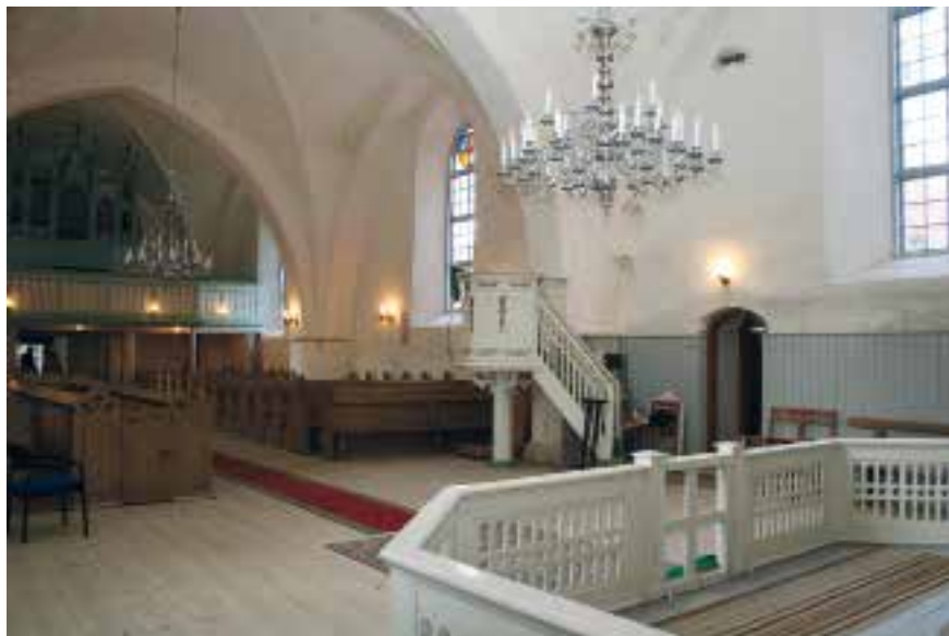
Abb. 8. Ausblick auf die nördliche Wand des Chorraumes. Rechts vom Leuchter befindet sich die zugemauerte Türöffnung des Treppenganges. Foto: Kaur Altkoa 2013
