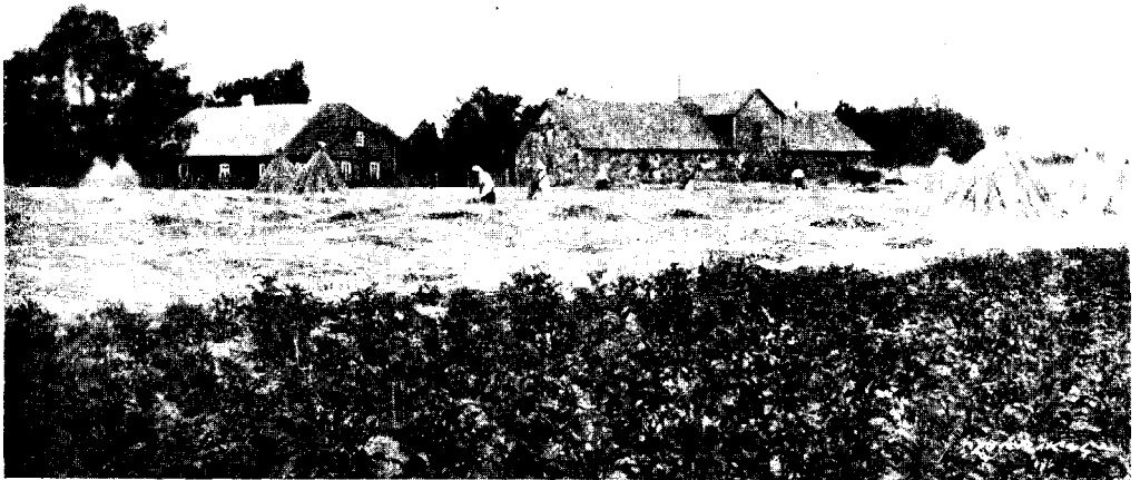
Abb. 71. Reicher Bauernhof (Gesinde) in Viljandimaa [Felliner Kreis]. (Übernommen aus dem Sammelwerk „Eesti“ mit Genehmigung des Kultusministeriums.) Zu S. 175.
